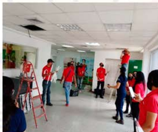
Equipo de Fundagenética en compañía de la Lcda. Riley Falcon, colocando las luminarias en las instalaciones de la institución
